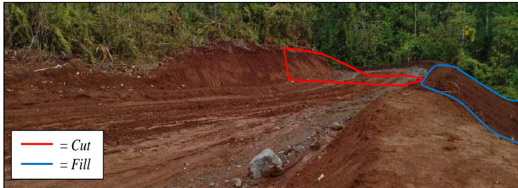
Gambar 5.15 : Hasil Cut and Fill Jalan Tambang
