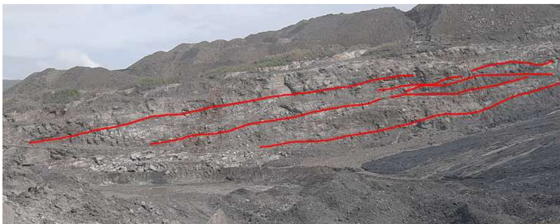
Gambar 10. Struktur laminasi weak layer di dinding Pit Bendili Prima Sawit
