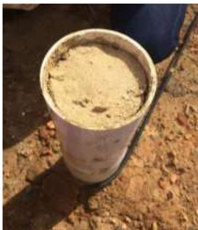
Gambar 2. Penurunan ( collapse ) material penutup lubang titik A4
