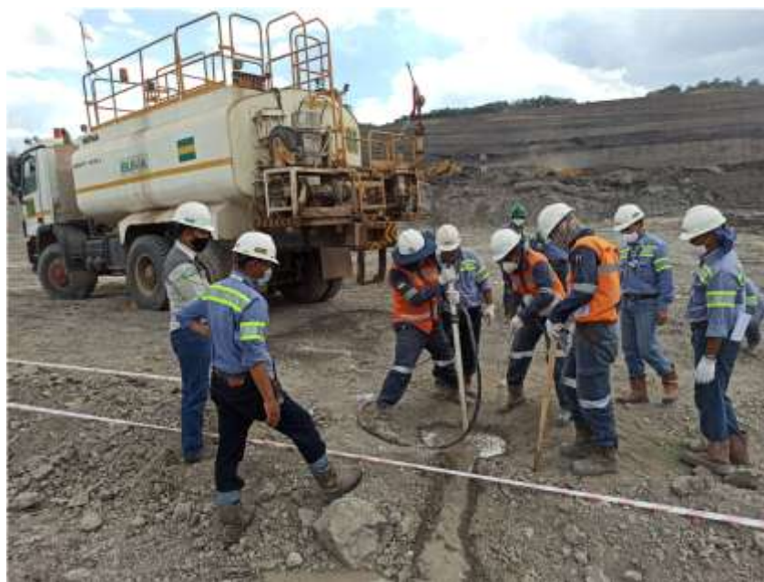
Gambar 2. Metode Penanganan Misfire dengan Flushing
