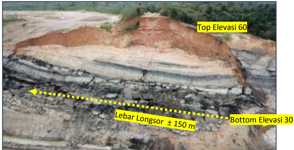
Gambar 4. body longsor High-Wall dengan kombinasi jenis batuan penyusun.
