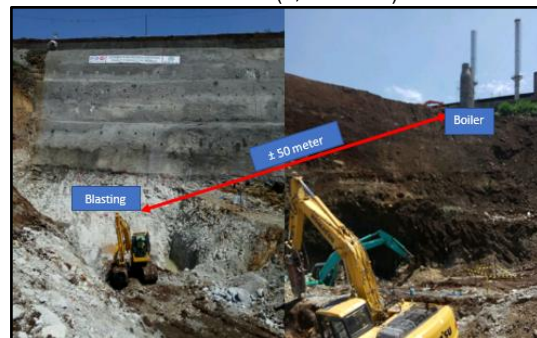
Gambar 1. Lokasi boiler dan jarak terhadap peledakan
