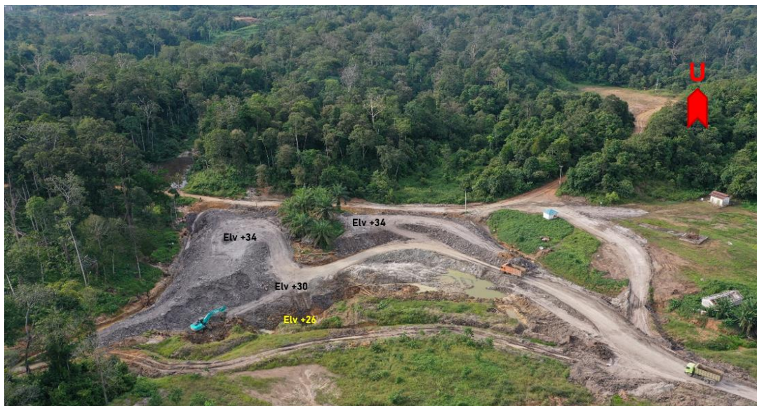
Gambar 13. Proses Fill RL+35 Sisi Utara dan Cut Sisi Selatan
