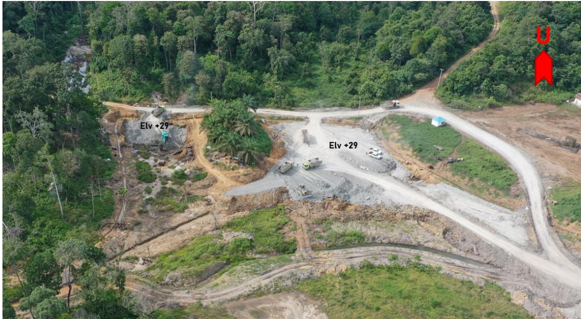
Gambar 12. Proses Fill Sisi Utara Timur dan Cut Sisi Utara Barat
